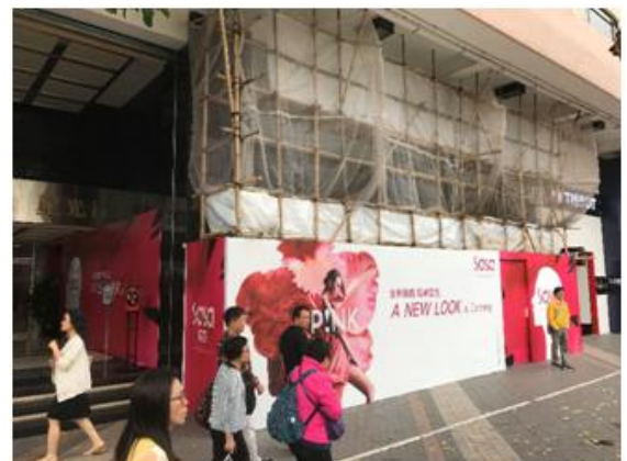
该铺现正进行装修工程。 (图片来源：永利行图片库)
