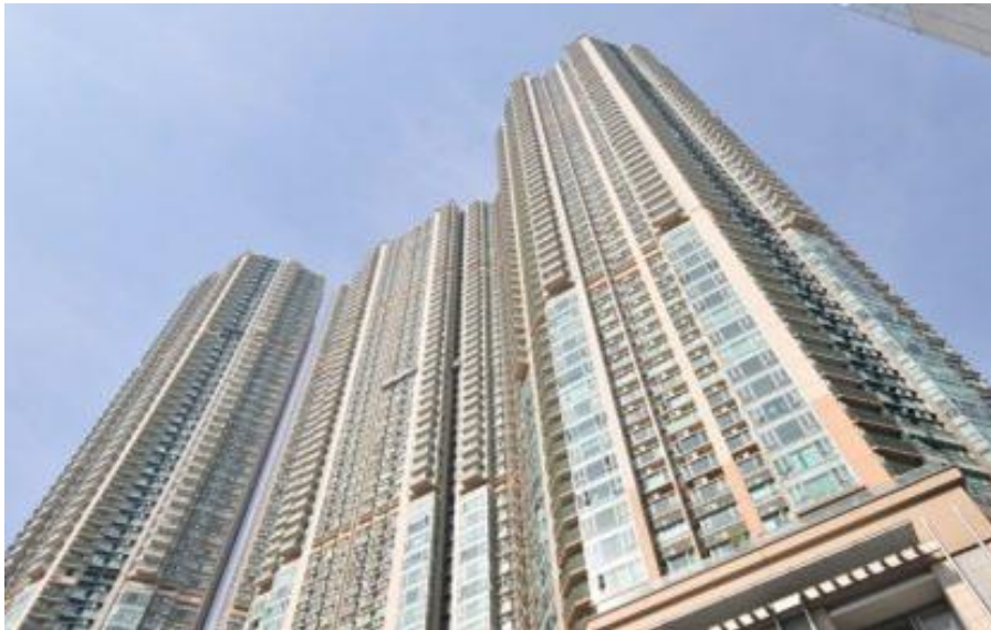
➤ 尖沙咀港景峰。 (图片来源：永利行图库)
