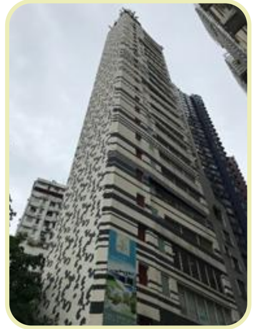
位于上环的荷里活道151号服务式办公室 (图片来源：永利行图库)
