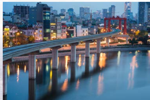
来源：2A线高架段，网上图片
