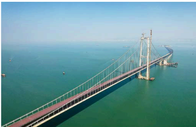
图为深中大桥连接至西人工岛。 (图片来源：网上图片)
