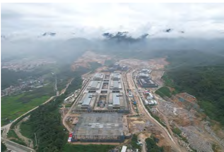
图为福州市民天国际物流中心项目。 (图片来源：福州市交通运输局网站)
