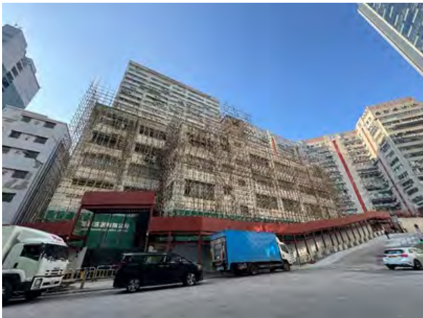
葵涌南華冷房工業大廈第三度更改發展用途，最新擬改作混凝土配料廠。 （圖片來源：永利行圖庫）
